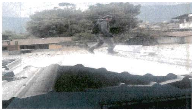
Foto7: INSTALACION DE LAMINA TROQUELA
