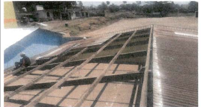
Foto 10 DESINSTALCION DE LAMINA DE ZINC
