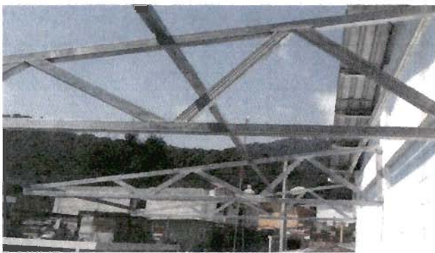
Foto 9: COLOCACION DE ESTRUCTURA PORTANTE.
