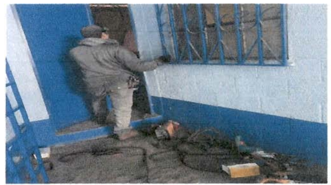
Foto 8: COLOCACION DE CHAPAS EN DIFERENTES AULAS.
