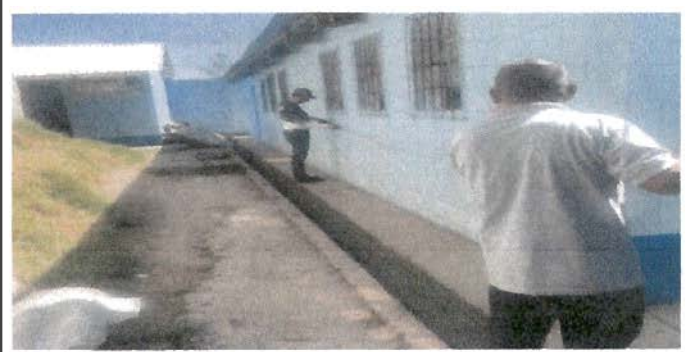
Foto 12: PINTURA DE PAREDES EXTERIORES.
