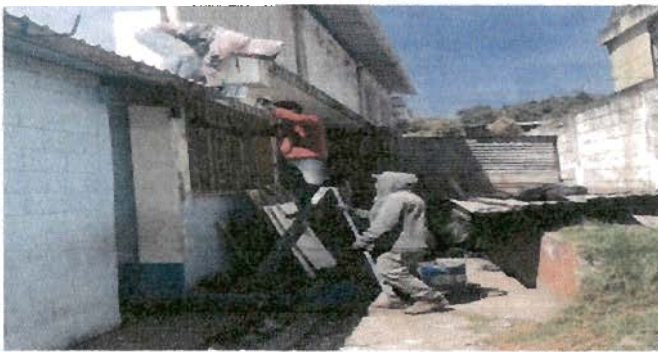
Foto 11: COLOCACION DE CANALES Y BAJADAS DE AGUA
